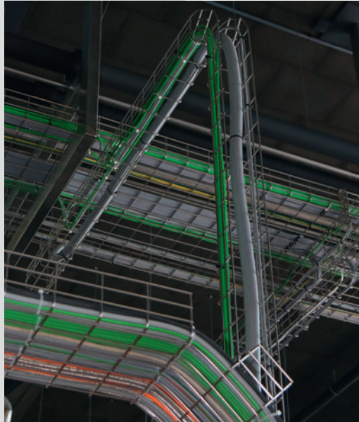
Abb. 3: Gitter-Kanal-Installation in unterschiedlichen Querschnitten in der Abfüllanlage (Bild: Lutz)
