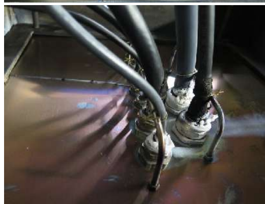
Schaden, unbeflammte Seite Damage, unexposed side
