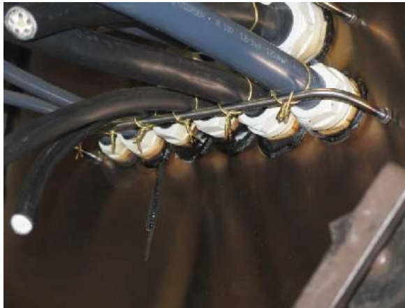
Schmelzen der Dichteinsätze Melting of sealing inserts
