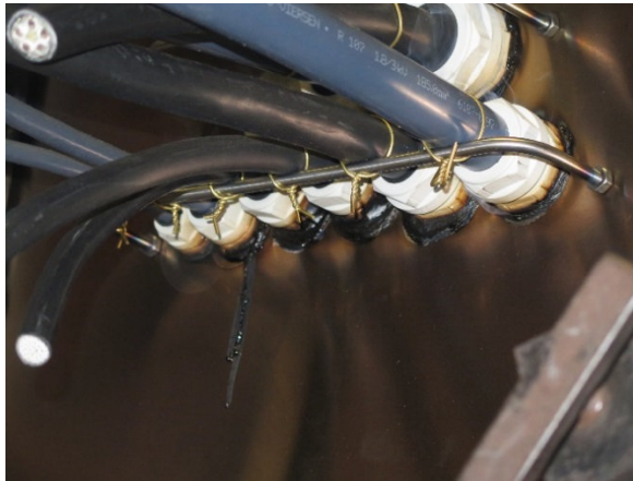
Schmelzen der Dichteinsätze Melting of sealing inserts
